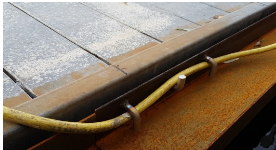
Kabel ist mit einem Schlag am Poller befestigt
